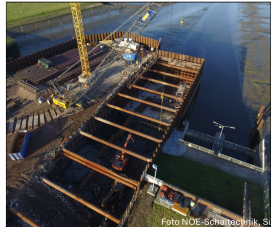
Foto NOE-Schaltechnik, St
