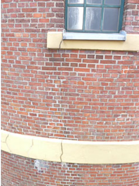
Der rund 50 m hohe Oldenburger Wasserturm an
