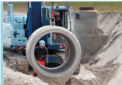
TIEF- UND ROHRLEITUNGSBAU
