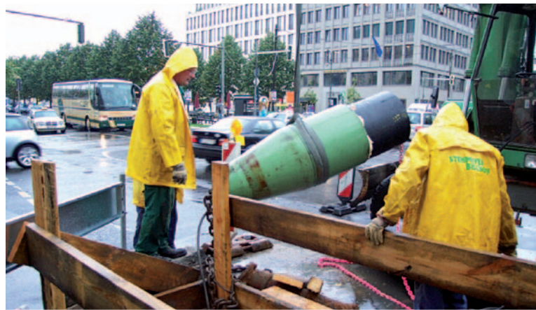
In Berlin, Unter den Linden, war ein Mischwasserkanal DN 400 aus Steinzeug/Beton zu erneuern und auf die Nennweite DN 500 aufzuweiten. Aufgrund des starken Verkehrsaufkommens und des wertvollen Baumbestands waren Tiefbauarbeiten auf ein Minimum zu beschränken. Die Lösung: Berstlining unter Einsatz von PEHD-Rohrmodulen DA 560.
