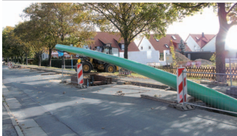
Blankenburg, Bornecker Straße: Einbau eines Langrohrstranges DA 355 PP-HM.
