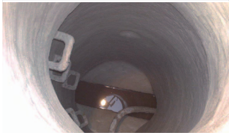
Mit dem KS-ASS-Verfahren (ERGELIT) beschichteter Einsteigschacht.
