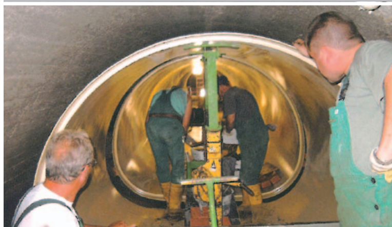
Berlin, Stubenrauchstraße: Transport der GFK-Module zur Einbaustelle.
