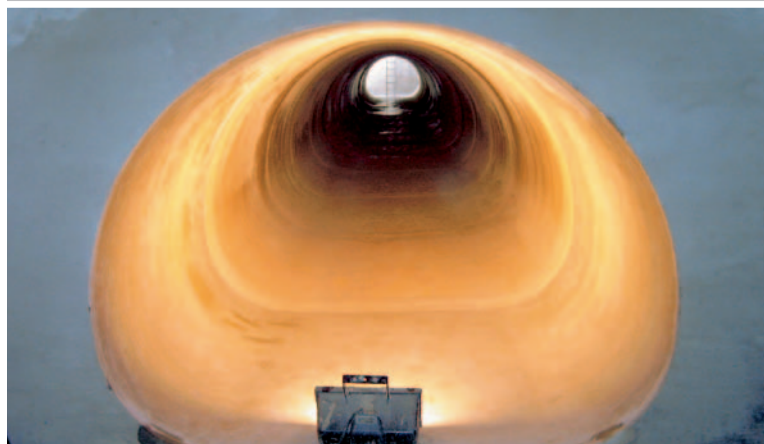
Fertig renovierter Sammler 2400/1800.
