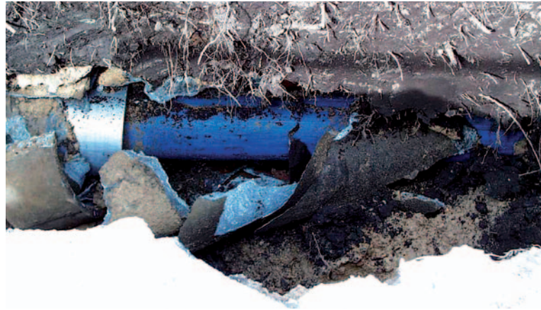
Mittels Berstlining lassen sich sowohl Versorgungsleitungen als auch Abwasserkanäle erneuern.
