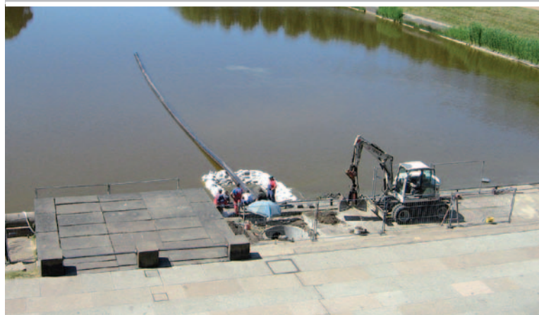
Leipzig-Probsteida: Vorbereitende Maßnahmen (Aufschwimmen) für den Einzug des PE-HD Stranges DA 355, SDR 17, in den Entwässerungskanal des Völkerschlachtdenkmal.
